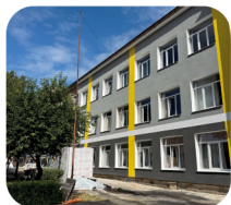
часткове утеплення фасаду Гімназії №11
