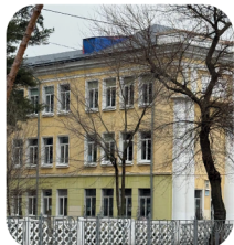
частковий капітальний ремонт покрівлі Гімназії №11
