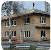
встановлення вікон та дверей в ДНЗ №455
