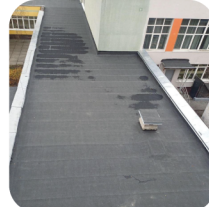
Гімназія №66: - капітальний ремонт покрівлі - часткове вимощення будівлі
