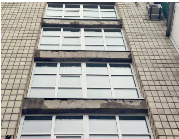
Проведена заміна вікон за адресою: вул. Василя Тютюнника, 56 (3 під'їзд)
