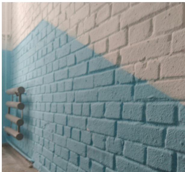
Ремонт під'їздів за адресою: вул. Василя Тютюнника (А. Барбюса), 5А
