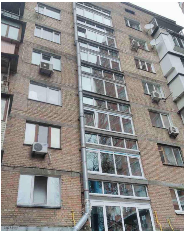
Проведена заміна вікон за адресою: вул. Велика Васильківська, 131
