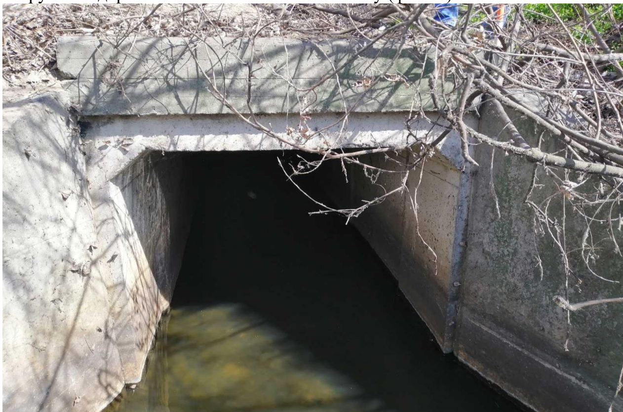
Фото 3 – Вид на оголовок колектора
