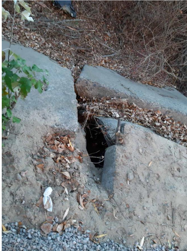
Фото 4 – Збірна залізобетонна плита над трубою та отвір між кільцями
