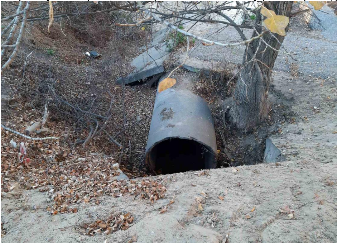
Фото 5 – Спряження водоперепускної труби з колектором
