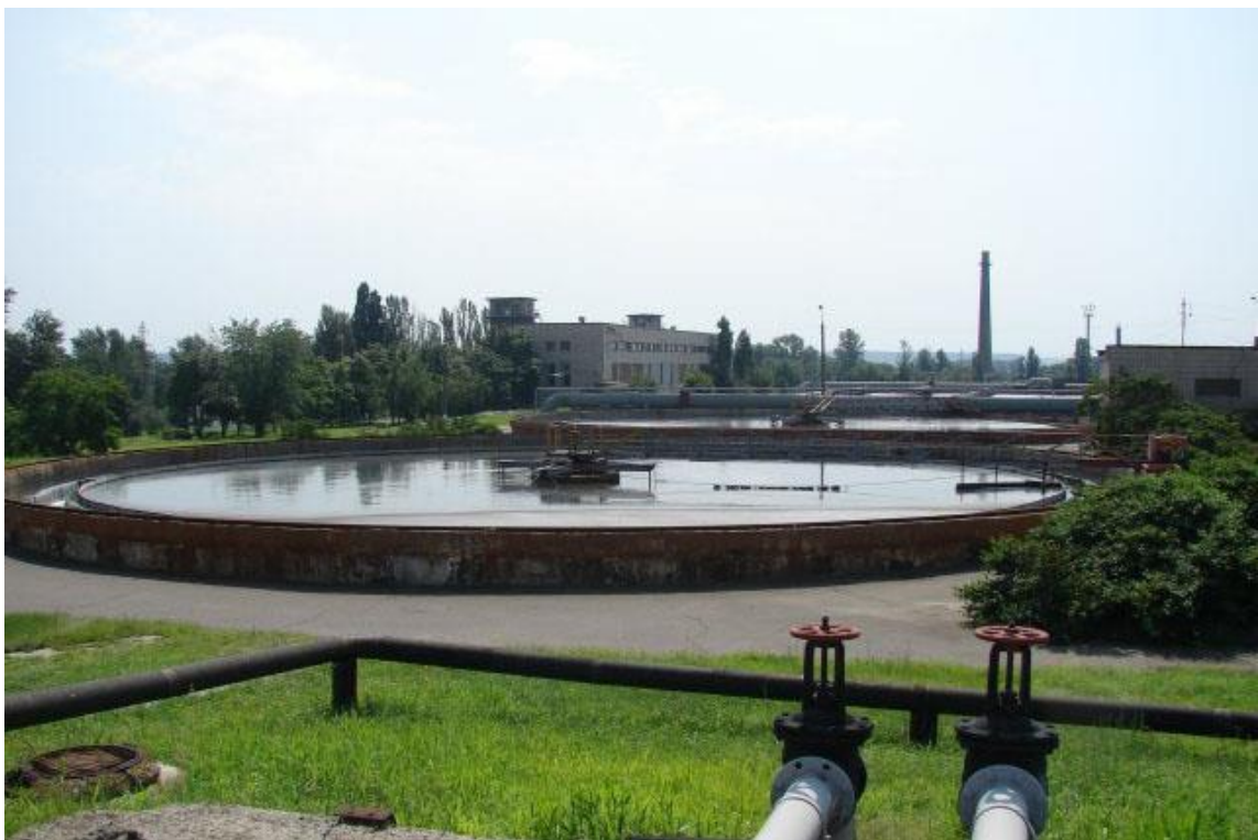
Малюнок 16 - Бортницька станція аерації ПАТ "АК"Київводоканал". Аеротенки
