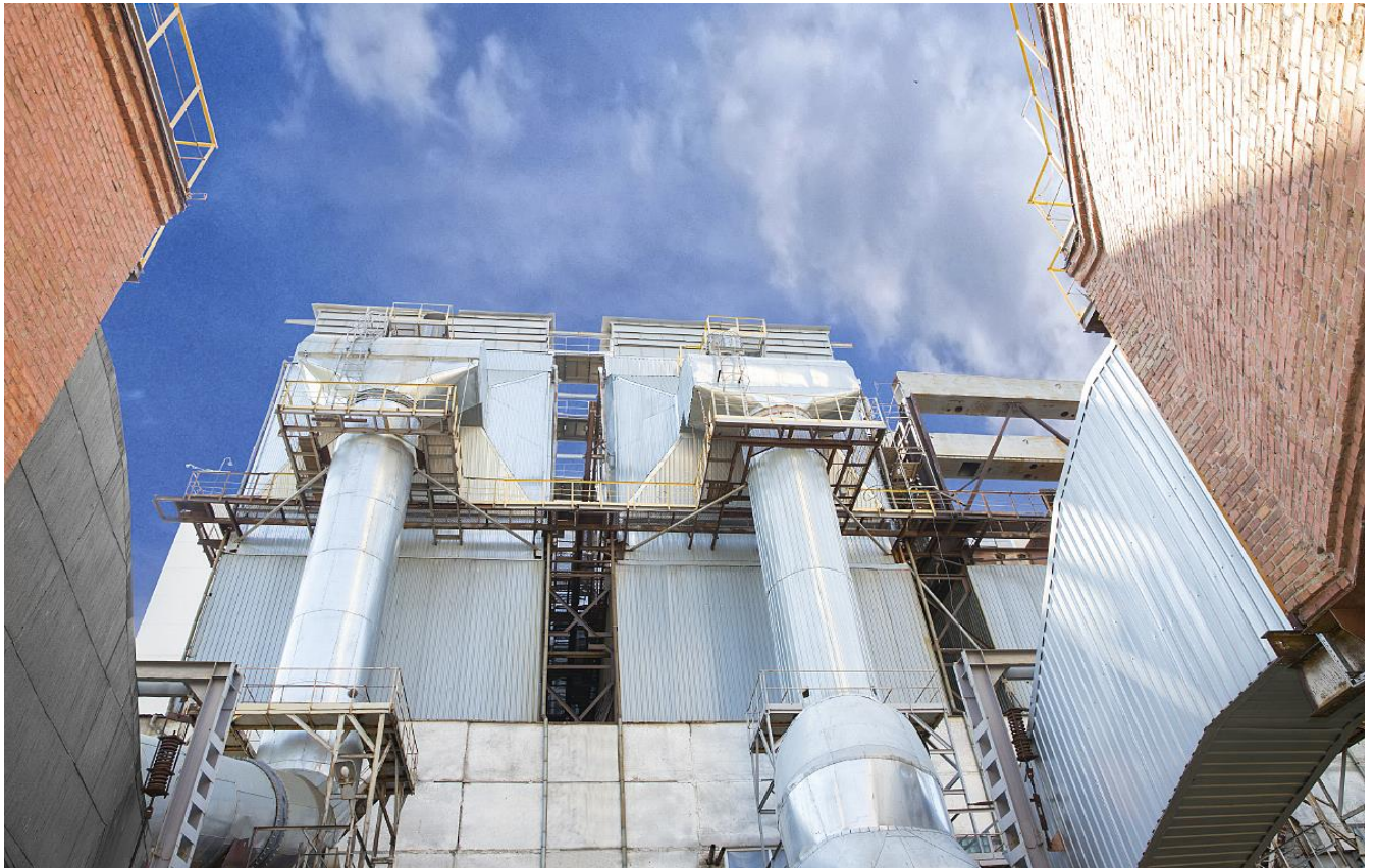
Рис. 14 Сміттєспалювальний завод «Енергія» КП «КИЇВТЕПЛОЕНЕРГО»
