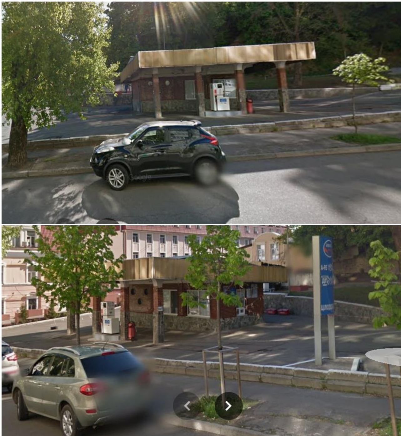
Рис.1.2. Фотоматеріали існуючої АЗС, що підлягає реконструкції
