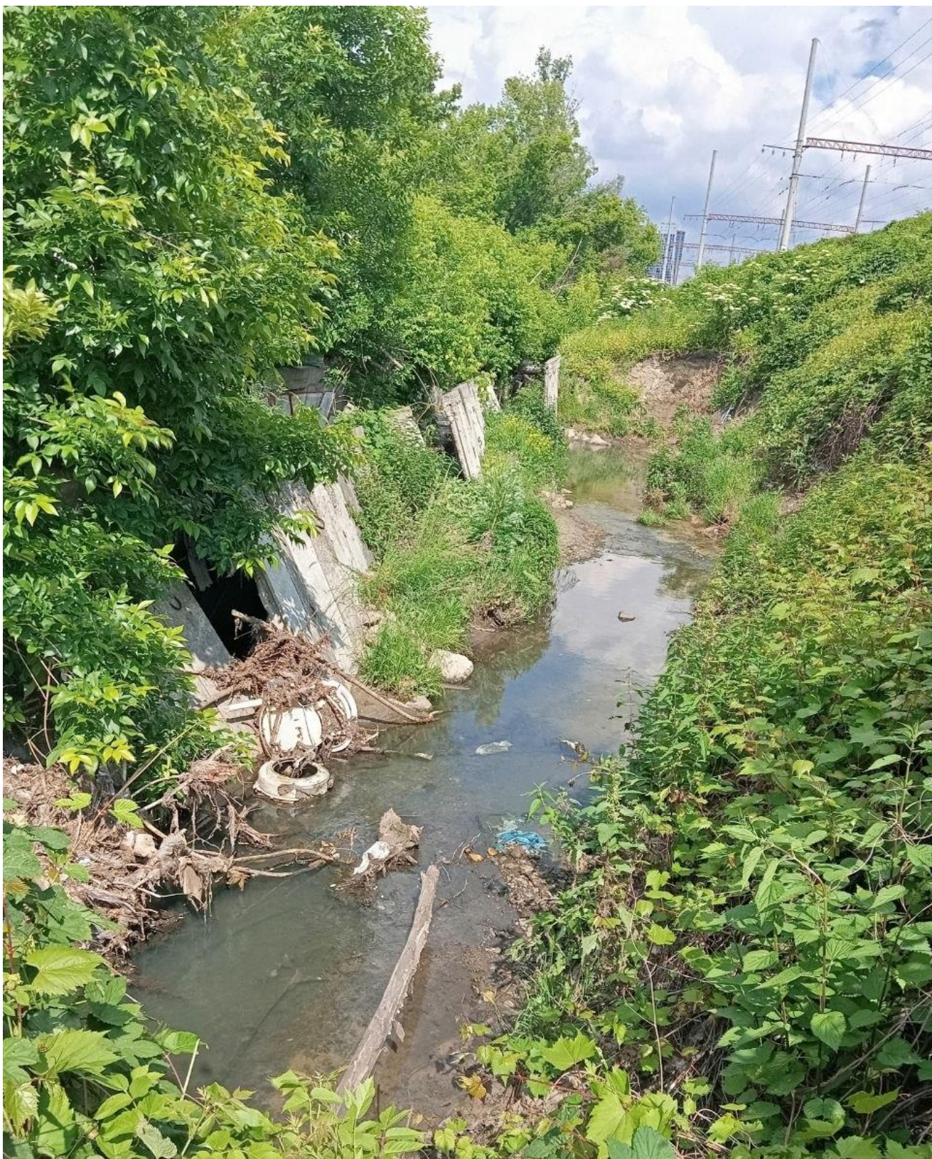
Фото 3 – Обвал елементів берегоукріплення русла р. Либідь. Руйнування укусу залізниці по правому березі річки
