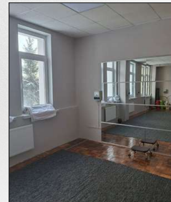
КАПІТАЛЬНИЙ РЕМОНТ ПРИМІЩЕННЯ ФІЗІОТЕРАПЕВТИЧНОГО ВІДДІЛЕННЯ (ВУЛ. СИМИРЕНКА, 10)
