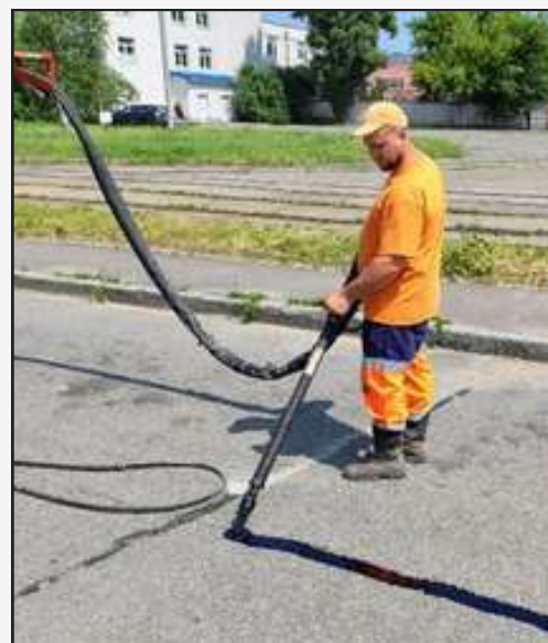
ЗАЛИВКА ТРІЩИН
