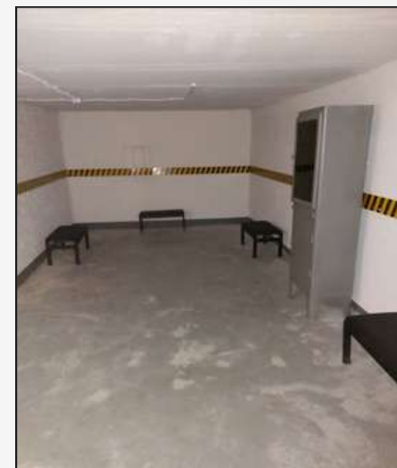
ПОТОЧНИЙ (ДРІБНИЙ) РЕМОНТ СТРУМЕНЕВО-ІН'ЕКЦІЙНИМ МЕТОДОМ
