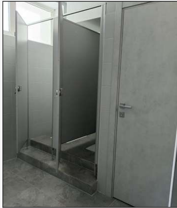
КАПІТАЛЬНИЙ РЕМОНТ МІСЦЬ ЗАГАЛЬНОГО КОРИСТУВАННЯ
