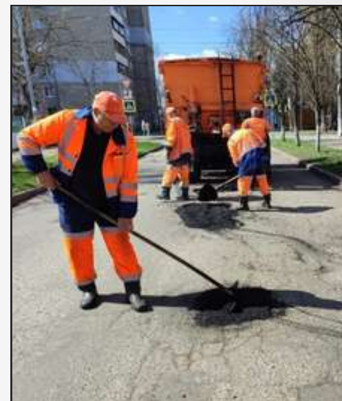
ПОТОЧНИЙ (ДРІБНИЙ) РЕМОНТ ПОКРИТТЯ БАЛАНСОВИХ ВУЛИЦЬ ТА ШТУЧНИХ СПОРУД
