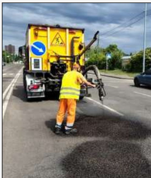
ПОТОЧНИЙ (ДРІБНИЙ) РЕМОНТ СТРУМЕНЕВО-ІН'ЄКЦІЙНИМ МЕТОДОМ
