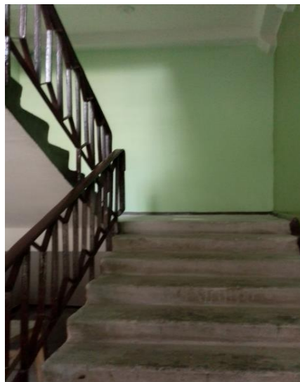
Ремонт сходової клітини вул. Василя Порика, 11
