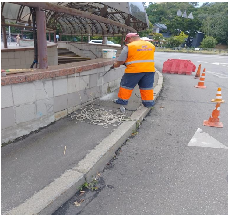
Очищення та ремонт оглядових та зливоприймальних колодязів
