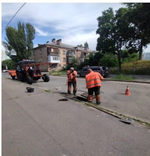
Очищення та ремонт оглядових та зливоприймальних колодязів
