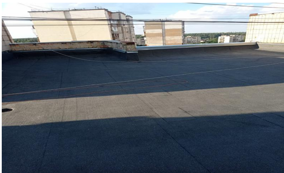
Капітальний ремонт покрівлі просп. Георгія Гонгадзе, 20г
