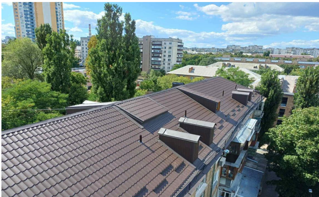
Капітальний ремонт покрівлі вул. Межова, 196
