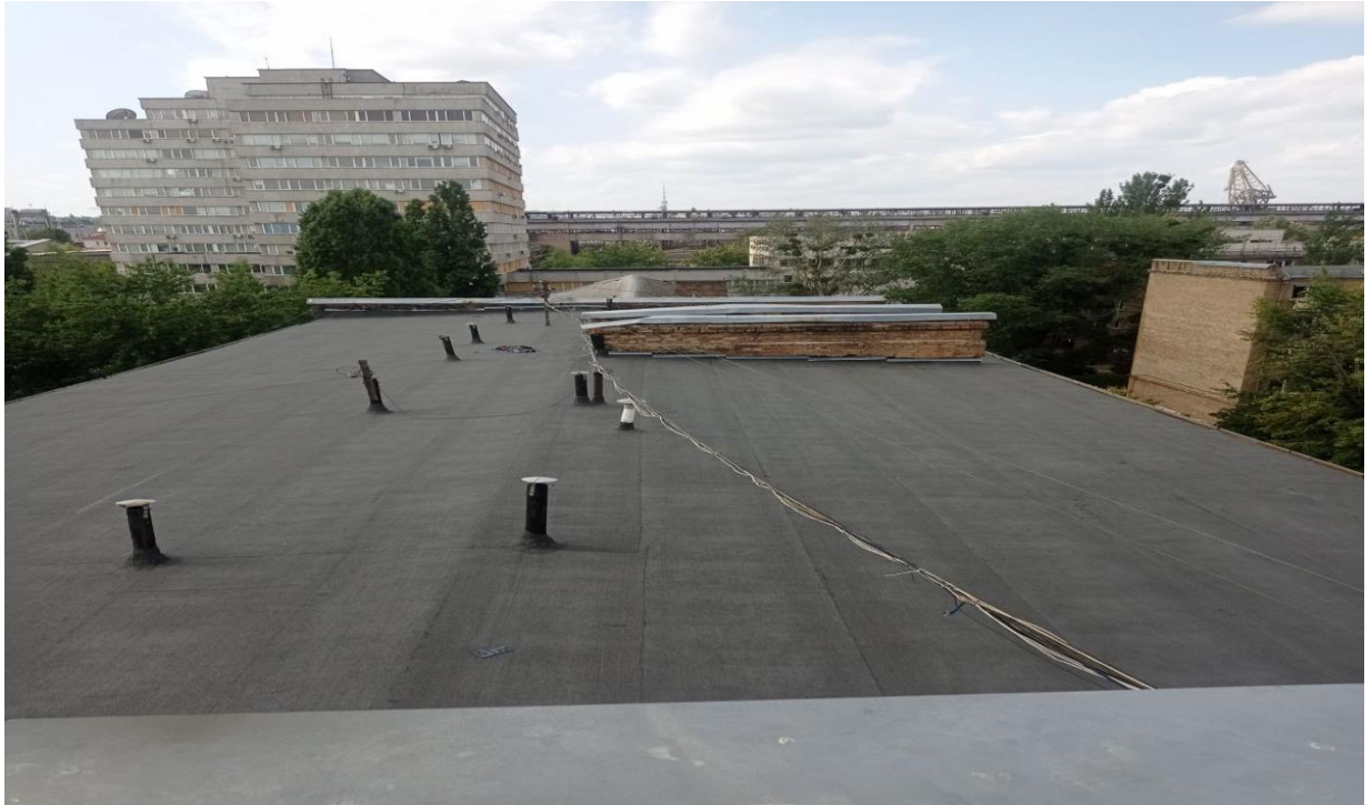
Капітальний ремонт покрівлі вул. Електриків, 28/30а, кор. 2
