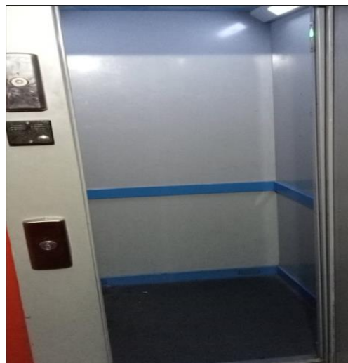
Реконструкція та заміна ліфта просп. Василя Порики, 15, під. 6
