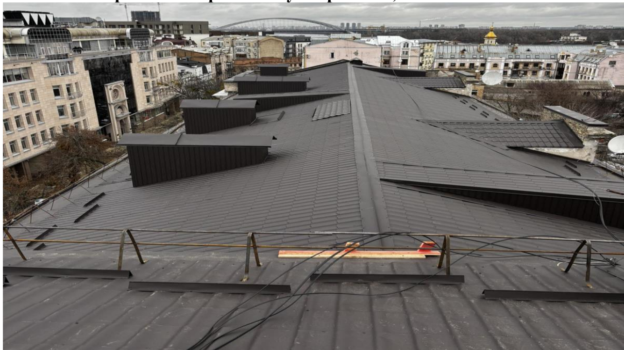
Капітальний ремонт покрівлі на вул. Братська, 10
