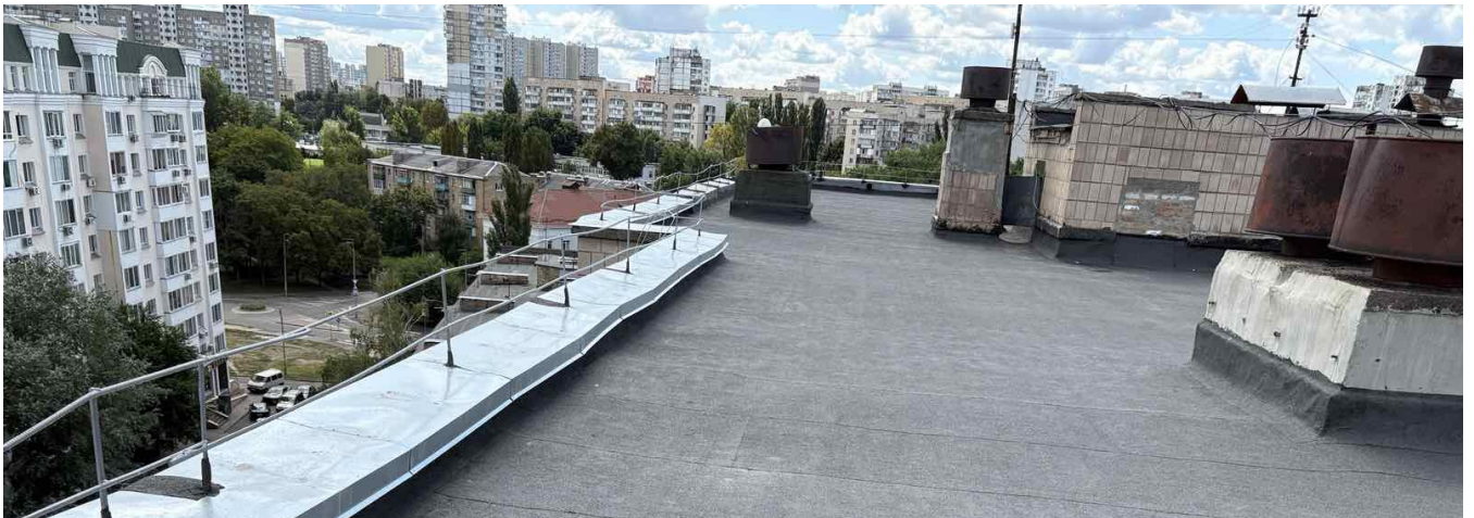
Капітальний ремонт покрівлі на вул. Вітряні Гори, 3
