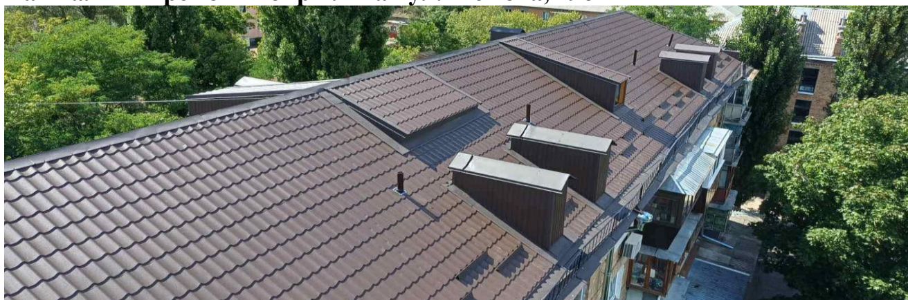
Капітальний ремонт покрівлі на вул. Межова, 196
