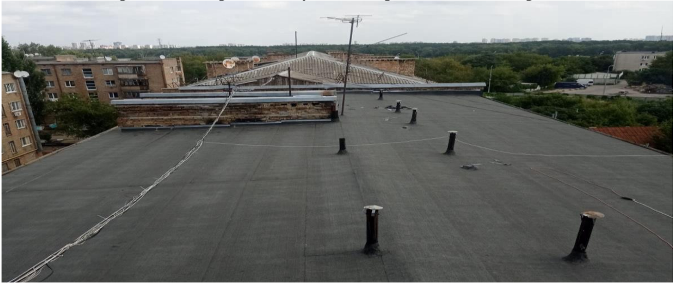
Капітальний ремонт покрівлі на вул. Електриків, 28/30а, кор. 2
