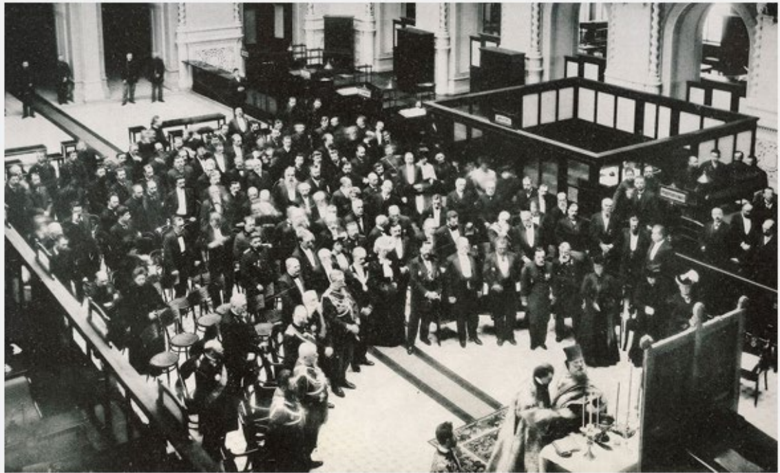
Освячення будівлі 22 лютого 1906 року
