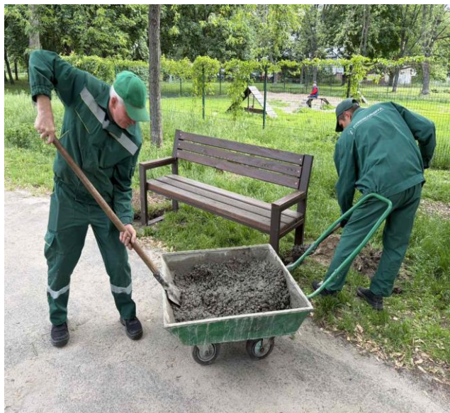
Встановлення лавок у парку відпочинку на вул. Бережанській, 10-20
