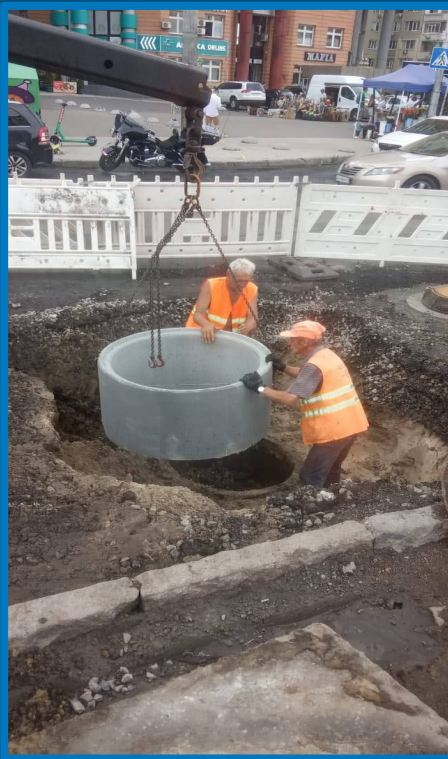
Ремонт оглядових колодязів на тр розв'язці просп Оболонського і вул Л Лук'яненка /середній ремонт/
