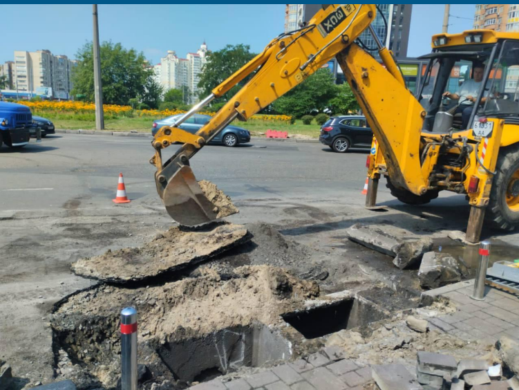
Поточний середній (ремонт о/к та влаштування бортового каменю) площа Мінська
