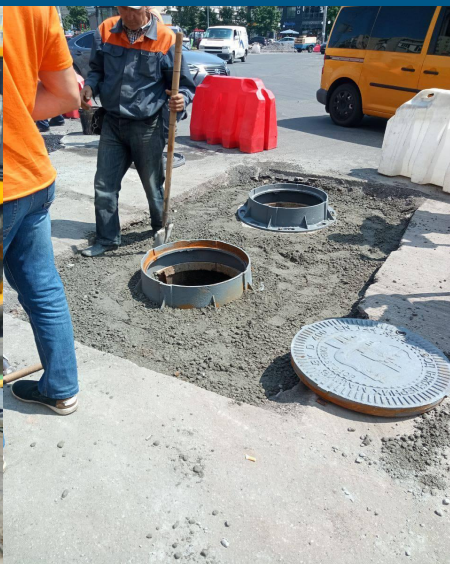
Поточний середній ремонт (ремонт зливоприймачів) площа Мінська
