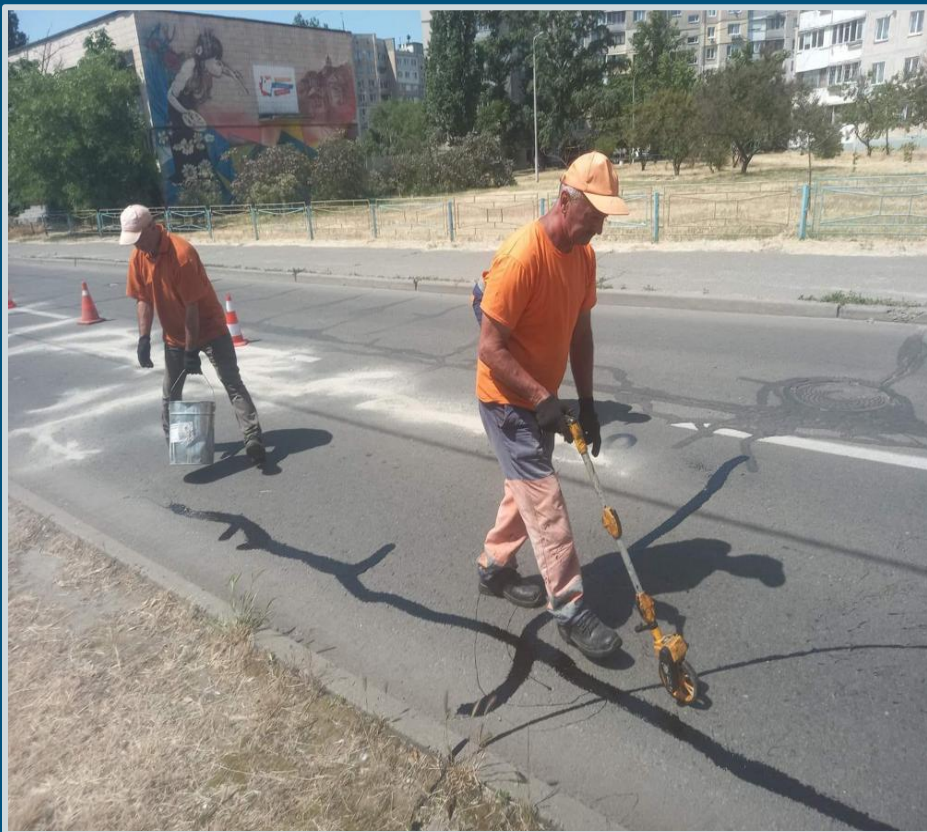
вул. Прирічна Заливка тріщин
