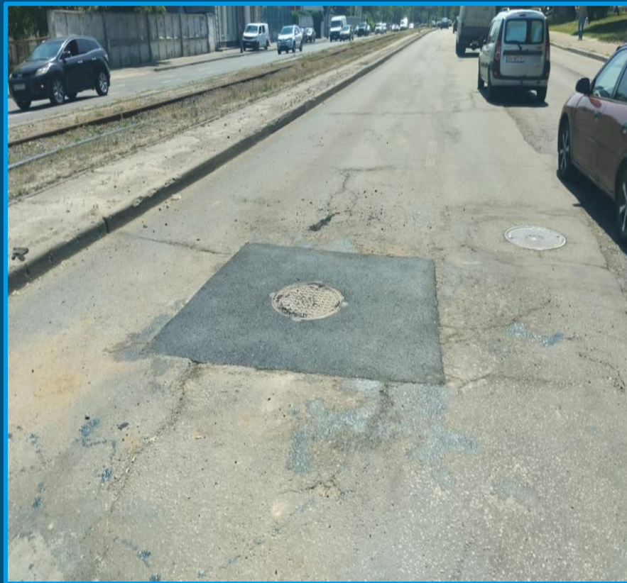
вул. Архипенка Поточний дрібний ремонт
