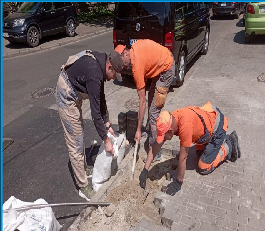
Ремонт тротуару вул. Пріорська
