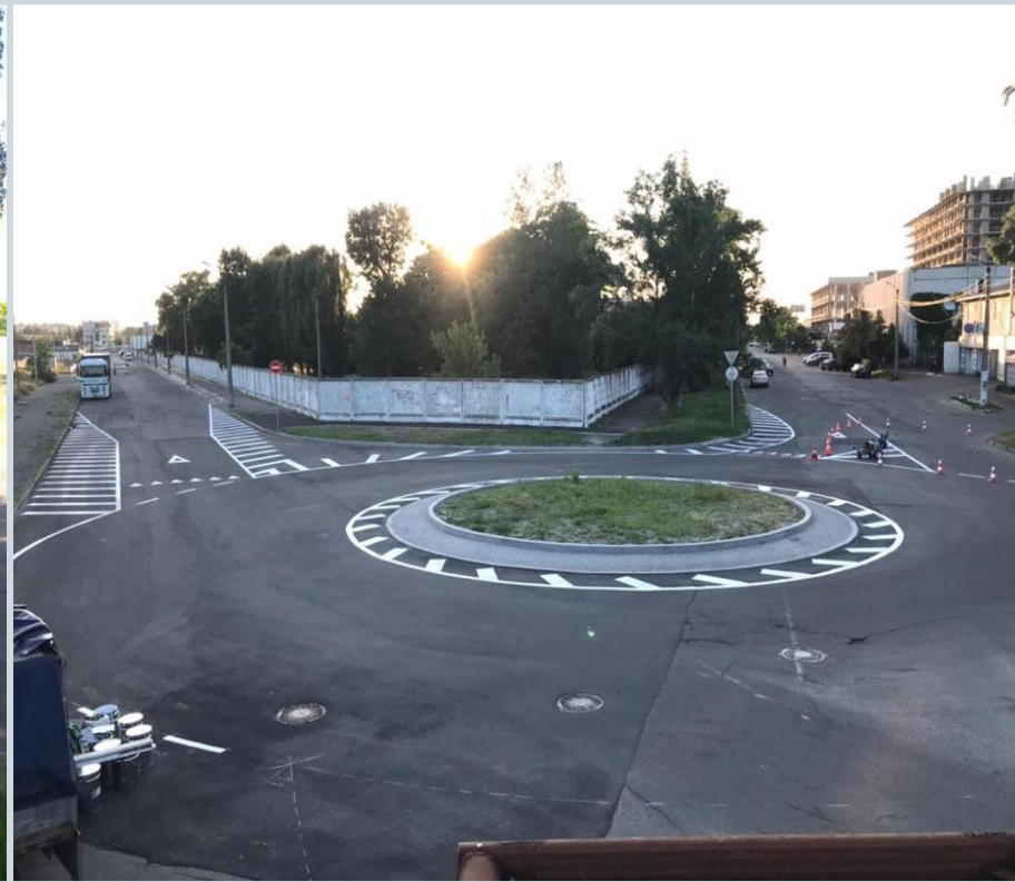
Нанесення дорожньої розмітки кругова розв'язка вул.Вербова- Ганзюка
