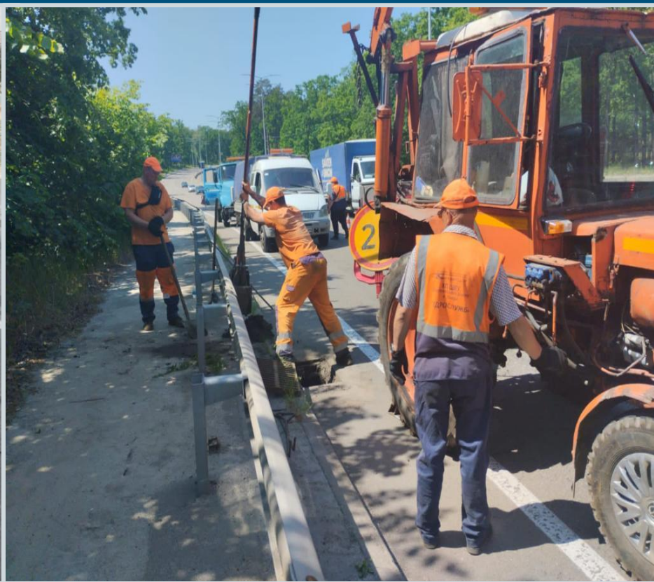
Механізоване очищення зливоприймачів Велика Кільцева
