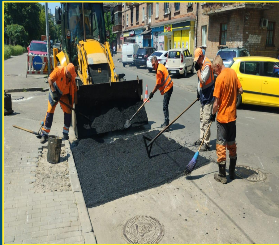
Відновлення розриттів (Київтеплоенерго) вул. Пріорська
