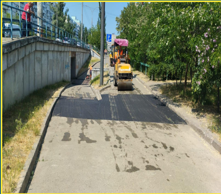
Відновлення розриттів (Київводоканал) вул. Йорданська
