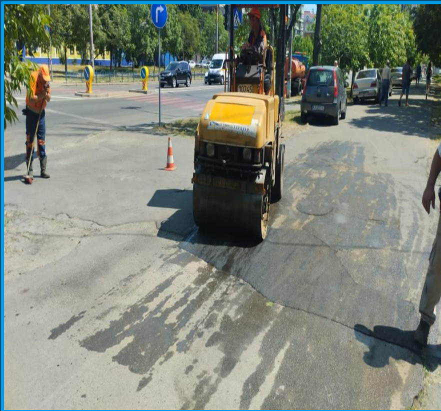
вул. Автозаводська Поточний дрібний ремонт
