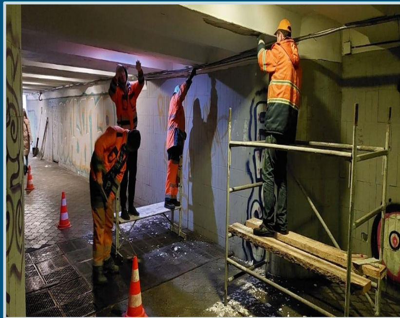
Ремонт підземного переходу по пр-ту Бандери (ТРЦ Городок)
