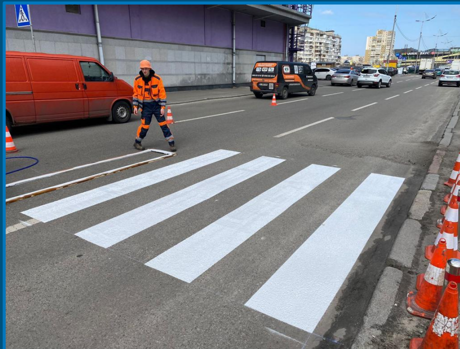
Нанесення дорожньої розмітки проспект Оболонський
