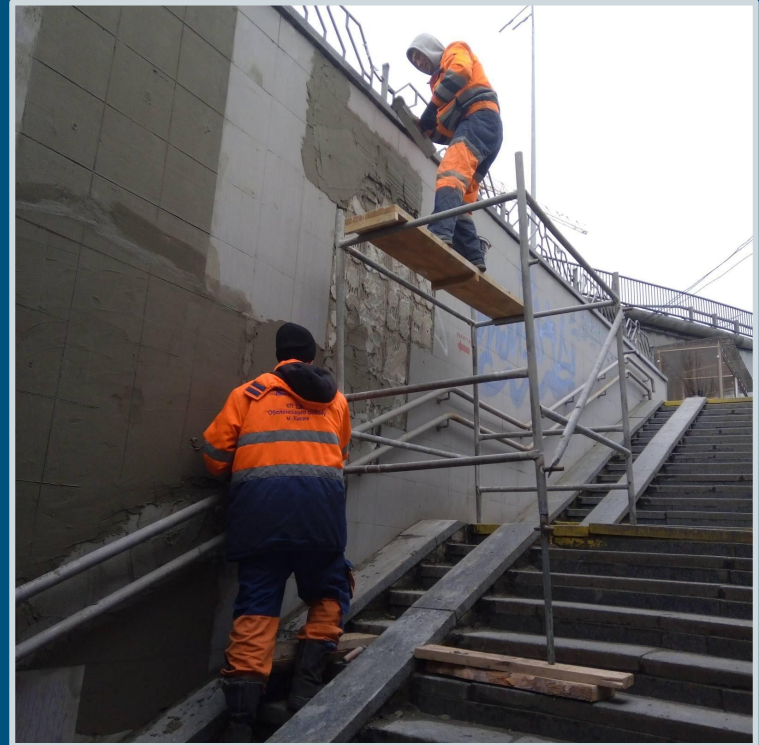
Ремонт підземного переходу на пр-т Бандери
