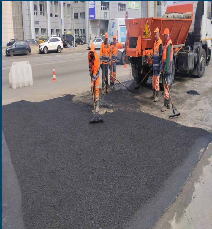
Поточний ремонт вул. Скляренко
