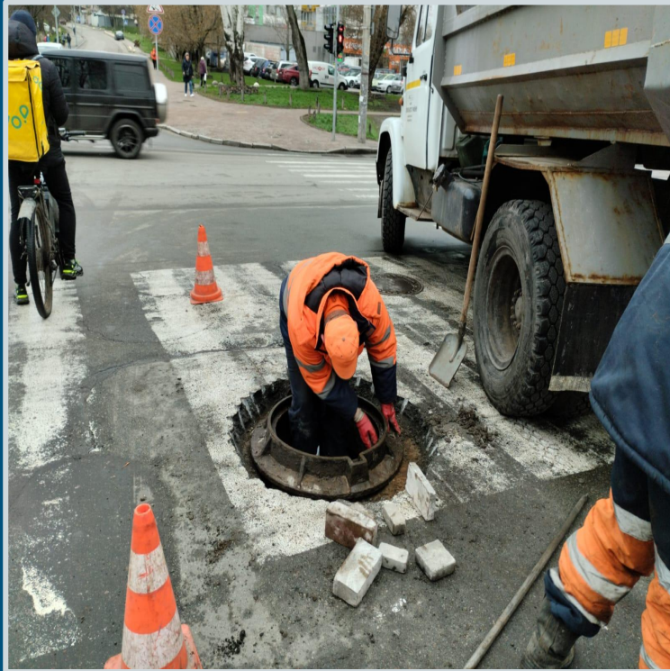
Ремонт оглядового колодязя вул. Пріорська
