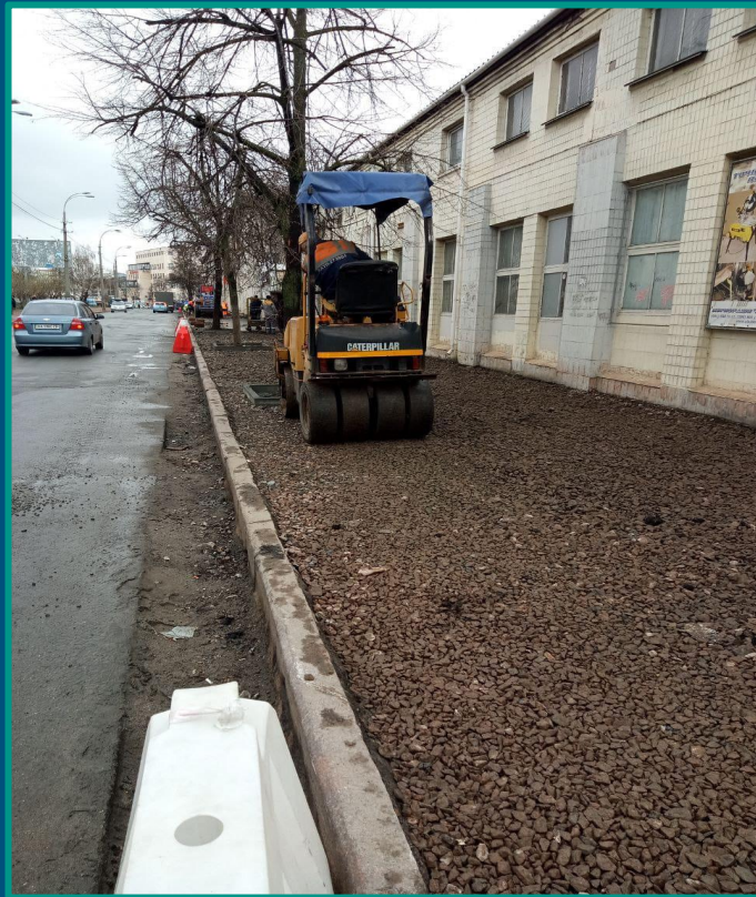
Підготовчі роботи (середній ремонт) вул. Сирецька
