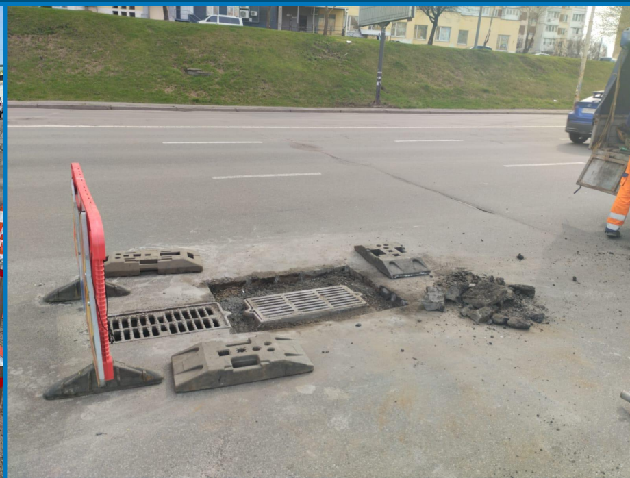
Ремонт зливоприймача вул. Полярна
