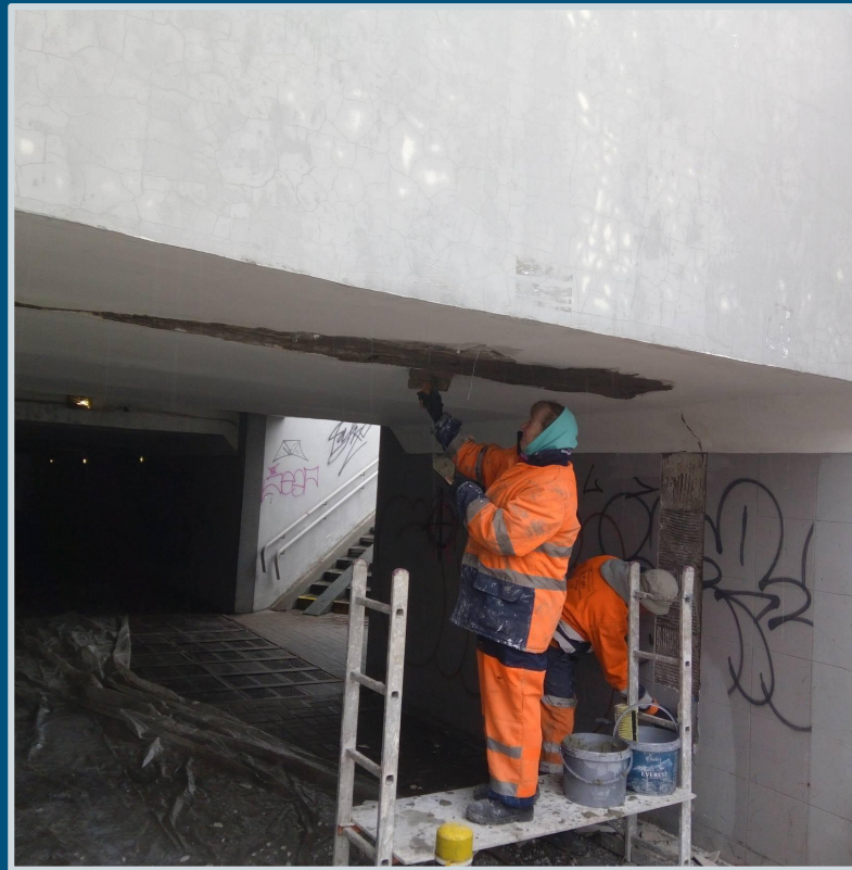
Ремонт підземного переходу на пр-т Бандери (залізнична станція Зеніт)
