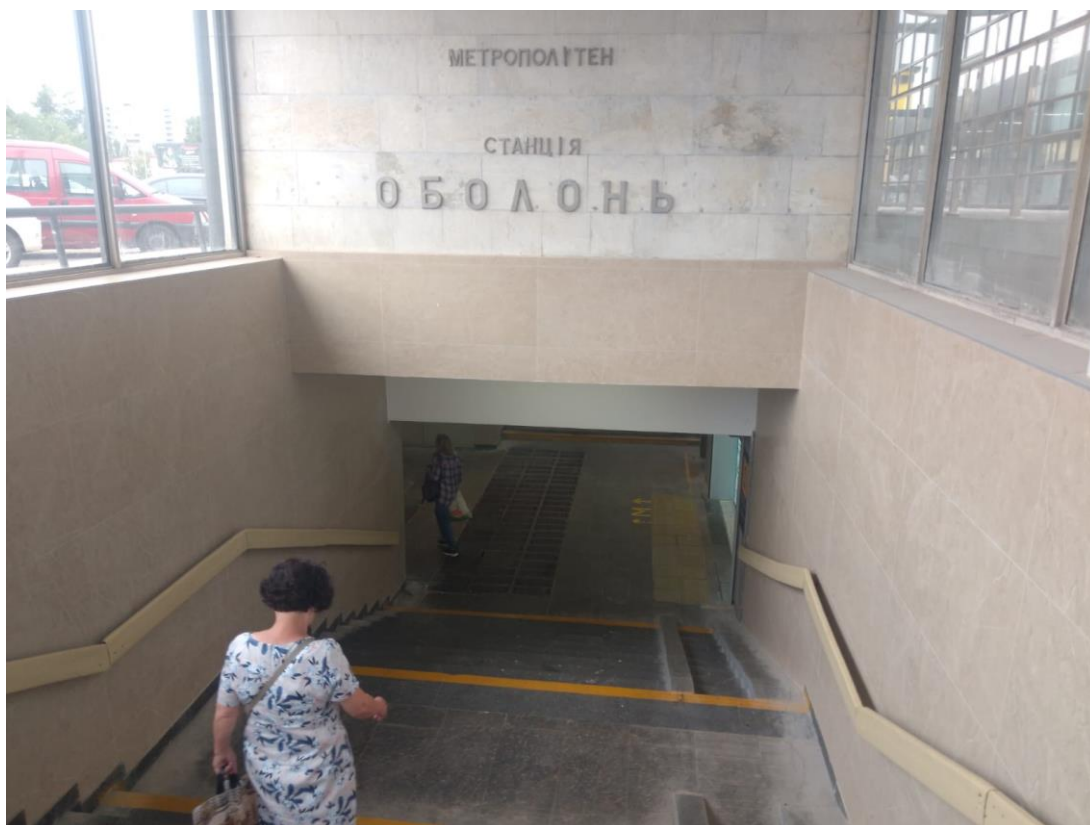
ремонт вхідної групи підземного пішохідного переходу (станція метро «Оболонь»)
