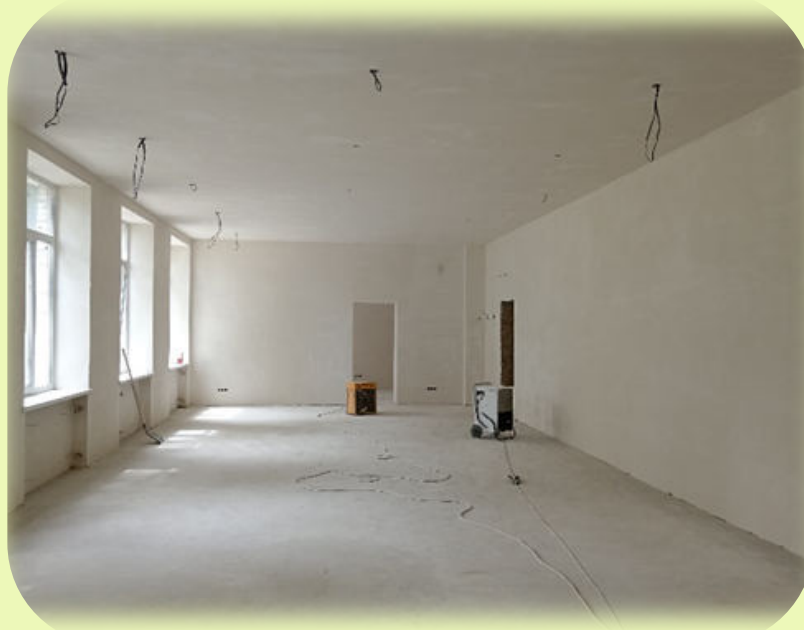
КАПІТАЛЬНИЙ РЕМОНТ ПРИМІЩЕНЬ ЛІЦЕЙ №319 ІМЕНІ ВАЛЕРІЯ ЛОБАНОВСЬКОГО , ПРОСП. ВАЛЕРІЯ ЛОБАНОВСЬКОГО, 146
