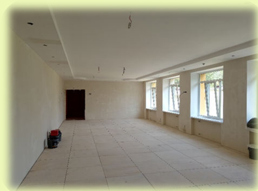
КАПІТАЛЬНИЙ РЕМОНТ ПРИМІЩЕНЬ ЗАКЛАД ДОШКІЛЬНОЇ ОСВІТИ (ЯСЛА-САДОК) № 506 ВУЛ. СТРАТЕГІЧНЕ ШОСЕ, 54
