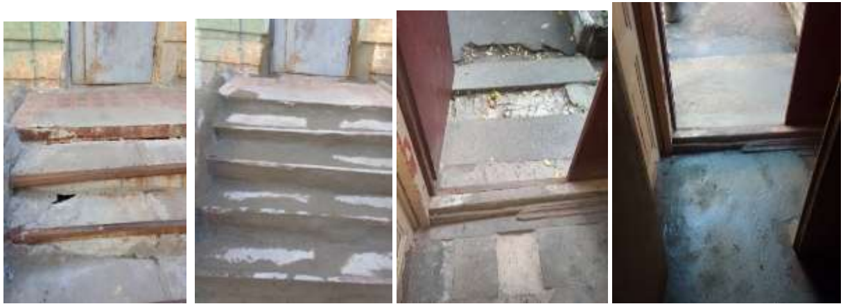
поточний ремонт сходи ганку; ремонт ганку
