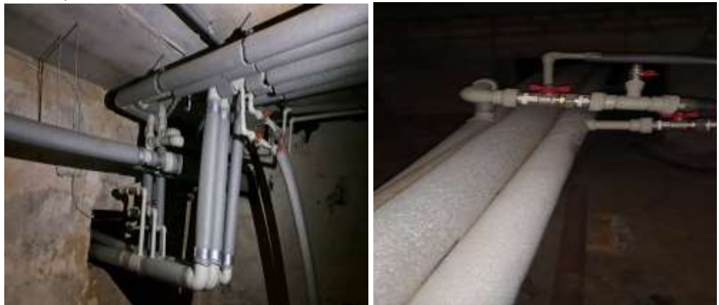
ремонт внутрішньобудинкових інженерних мереж
