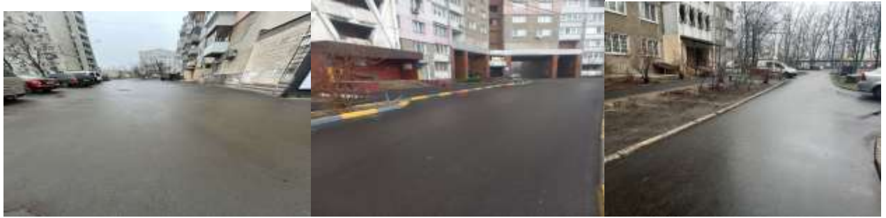
ремонт асфальтового покриття
