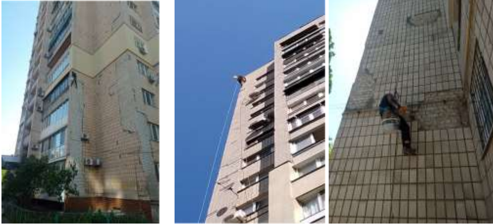
простукування фасадної плитки
