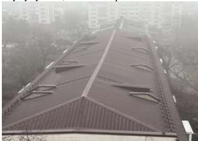
вул. Юлії Здановської, 21/14 ( капітальний ремонт покрівлі)
