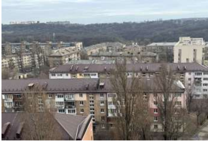
провулок Коломийський, 8, 10, 12 ( капітальний ремонт покрівель)
