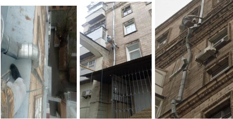
ремонт водостічної системи
