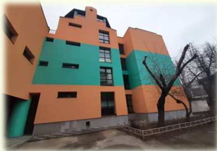
Після капітального ремонту
