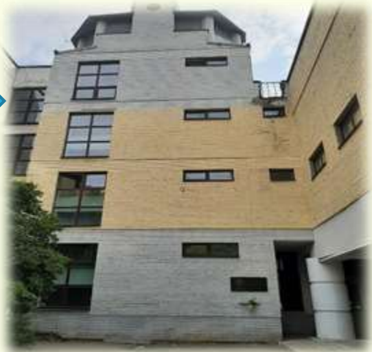
До капітального ремонту
