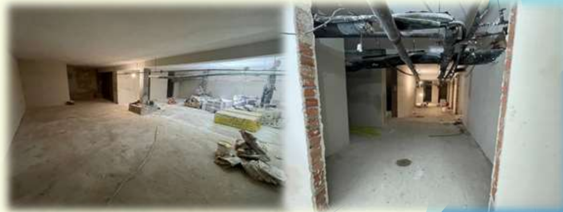
Виконання робіт 1 пускового комплексу (укриття)
