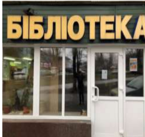
Ремонт вхідної групи бібліотеки ім.М.Гоголя (вул. В.Васильківська, 136)
