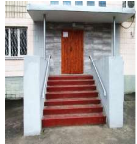
Ремонт вхідної групи бібліотеки ім.Стельмах (вул.Лятошинського, 26Г)
