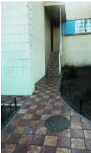
Ремонт вхідної групи ДМШ №38 (вул.Якубовського, 7-Д)
