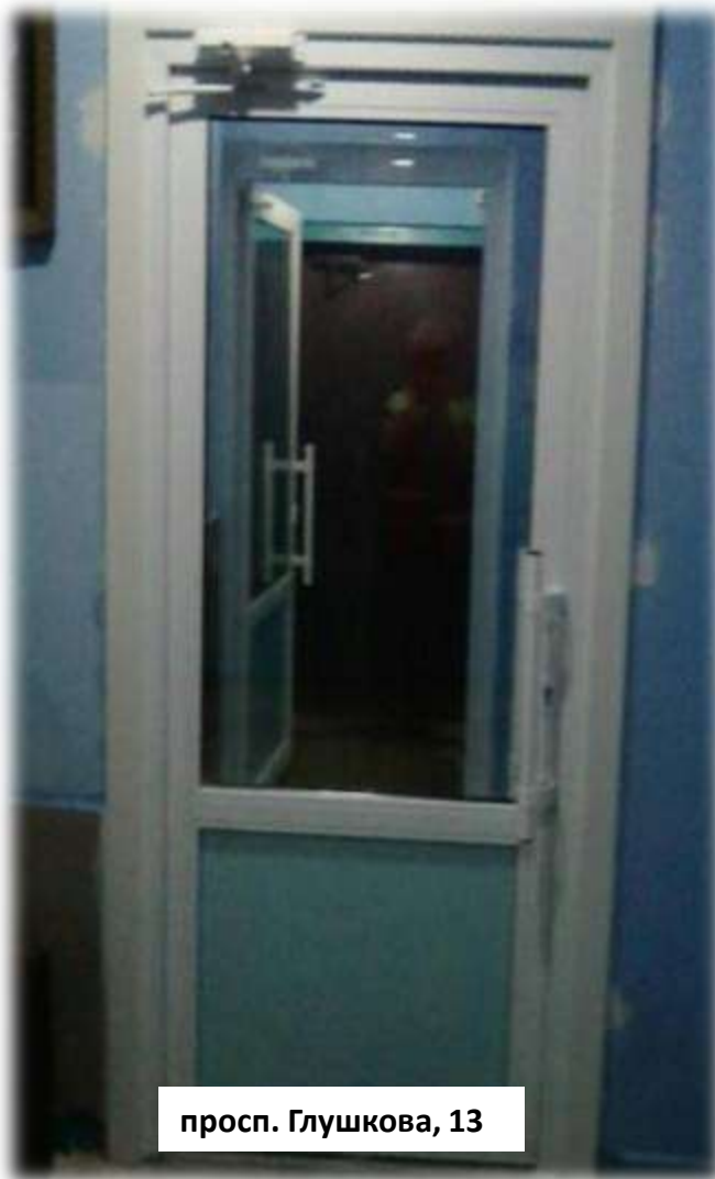
Капітальний ремонт сходових клітин
