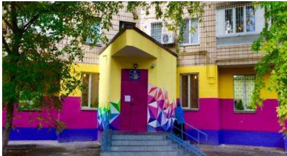
Ремонт вхідної групи ДХШ №9 (вул. Смолича, 4)
