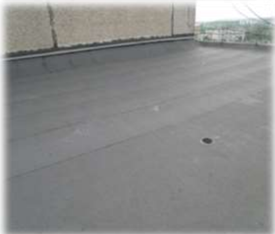
поточний ремонт покрівель в 221 ж/б
