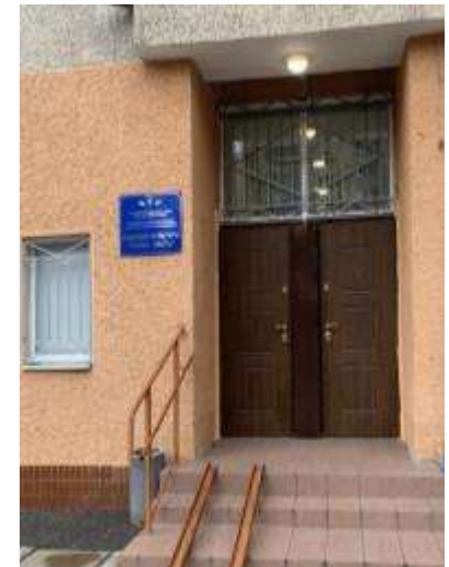
Ремонт вхідної групи БК «Конча-Заспа» (вул.Генерала Матикіна, 10)
