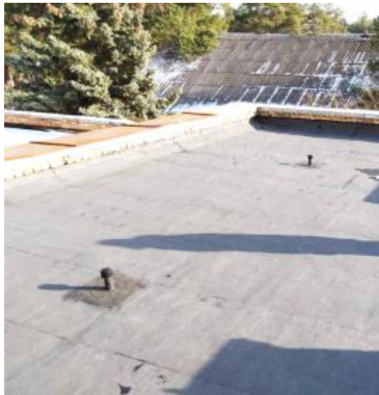
Поточний ремонт покрівлі та частини приміщення кіноконцертної зали Будинку культури «Конча- Заспа», вул. Генерала Матикіна, 10
