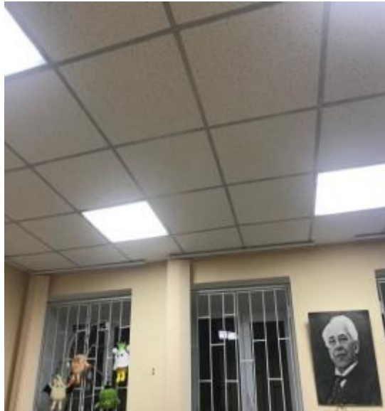
Поточний ремонт частини приміщення з заміною входних дверей Київської театральної школи-студії, вул. Велика Васильківська, 76-Б
