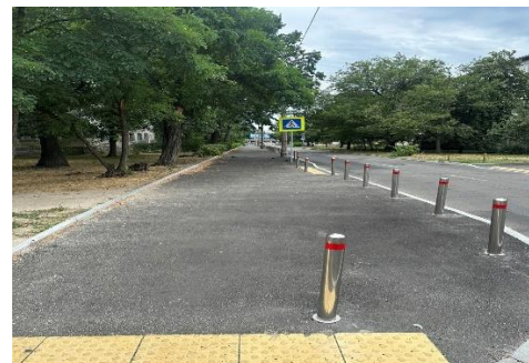
Поточний (дрібний) ремонт вулиці Міста Шалетт
