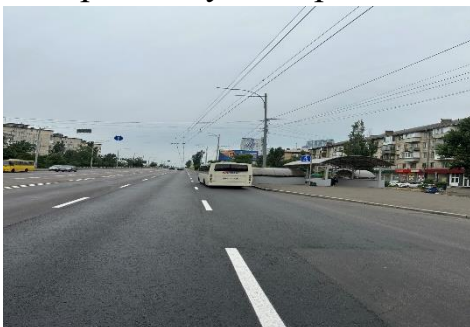
Поточний (дрібний) ремонт проспекту Соборності
