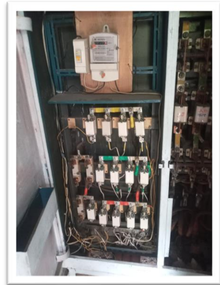
Капітальні ремонти електрощитових житлових будинків
