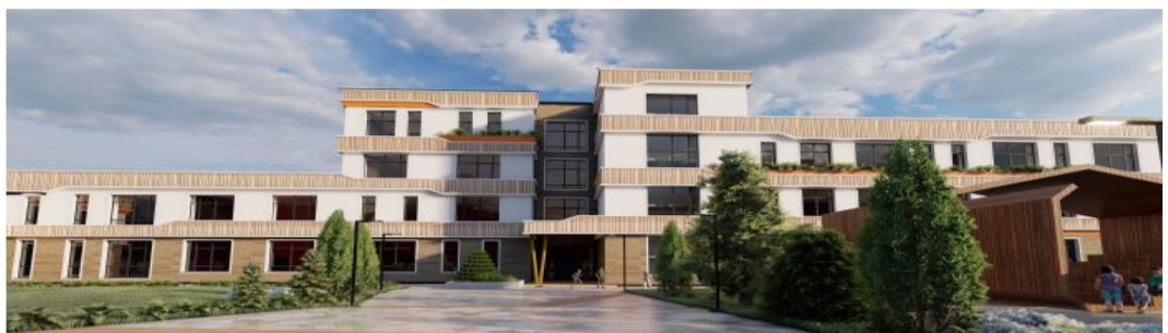
Загальний вигляд школи на 36 класів мікрорайоні житлового масиву Вигурівщина-Троєщина Деснянському районі міста Києва /Початкова школа/
