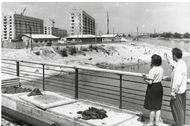
Будівництво житлових будинків на Русанівці. Фото 1960 р.
