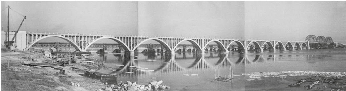
Будівництво Дарницького залізничного мосту.
