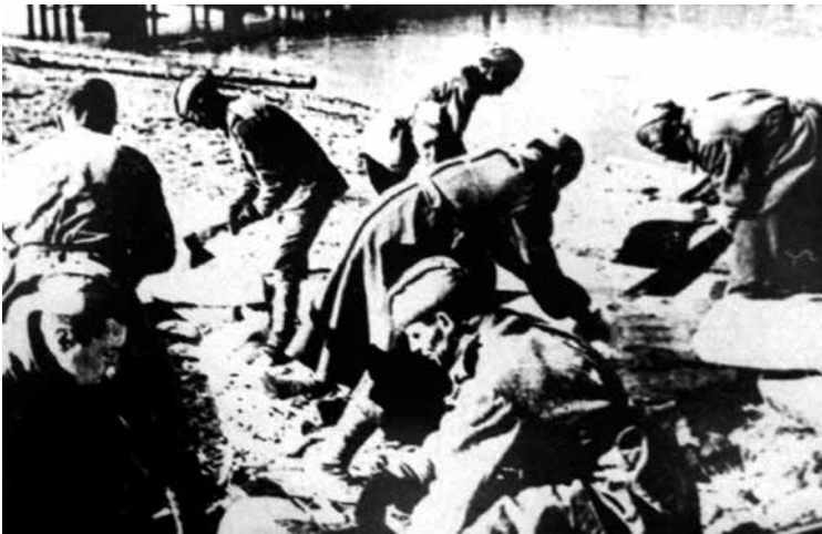
Бійці інженерного батальйону відбудовують міст через Дніпро. Фото 1943 р.
