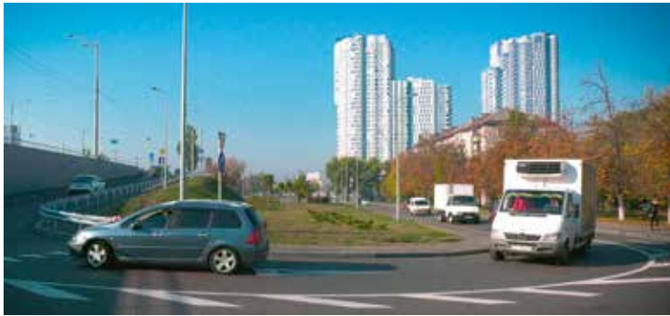
Дорожня розв'язка на перехресті вулиць Вифлеємської і Соборності після реконструкції 2018 р.
