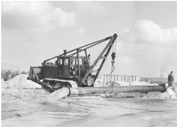
Гідронамив ґрунтів під будівництво Русанівського острова. Фото 1961 р.
