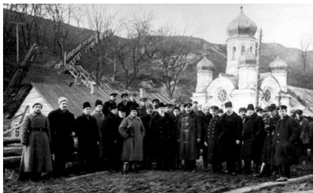
Груповий знімок учасників будівництва мосту ім. Є. Бош, у центрі – Є. Патон. Фото 1925 р.
