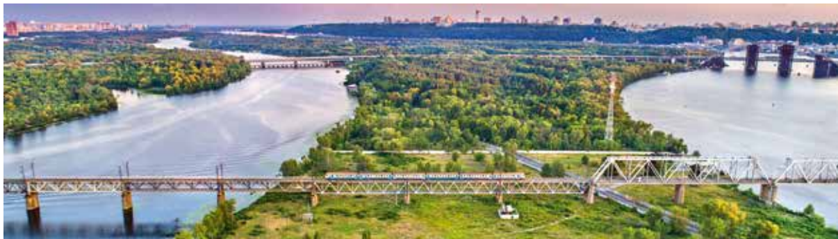
Київська міська електричка перетинає Петрівський залізничний міст. На задньому плані праворуч – триває будівництво Подільського моста. Фото 2018 р.
