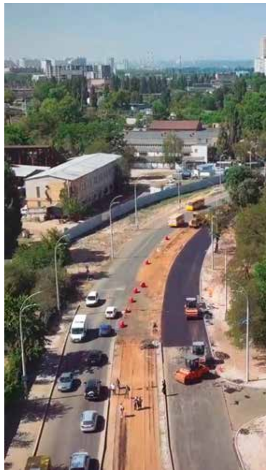
Ремонт вулиці Алматинської, 2018 р.
