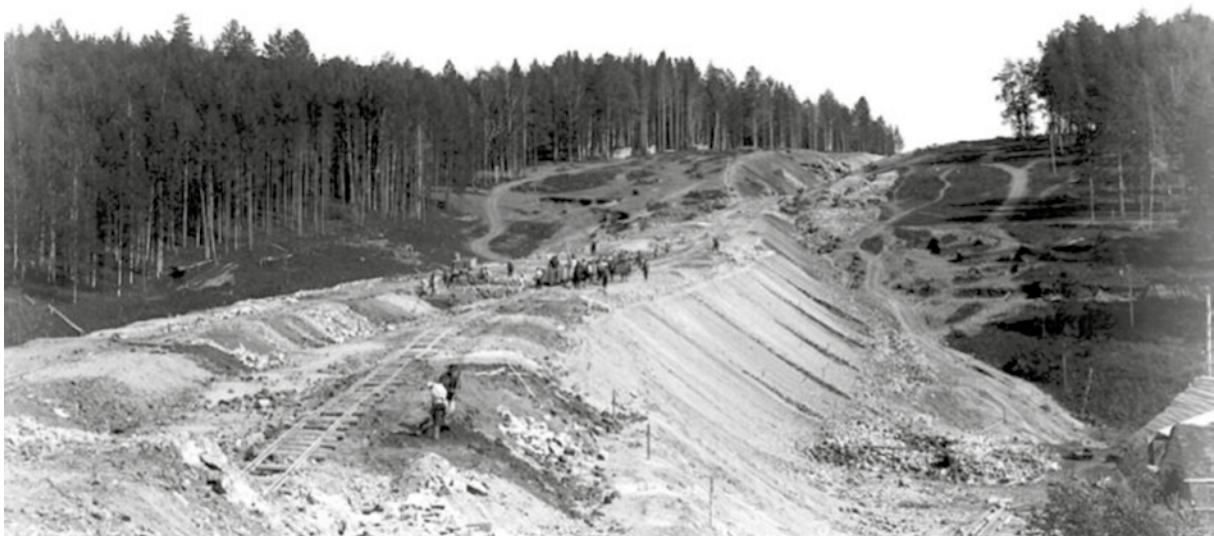
Будівництво залізничної колії у напрямку Полтави поблизу Дарниці. 1898 р.
