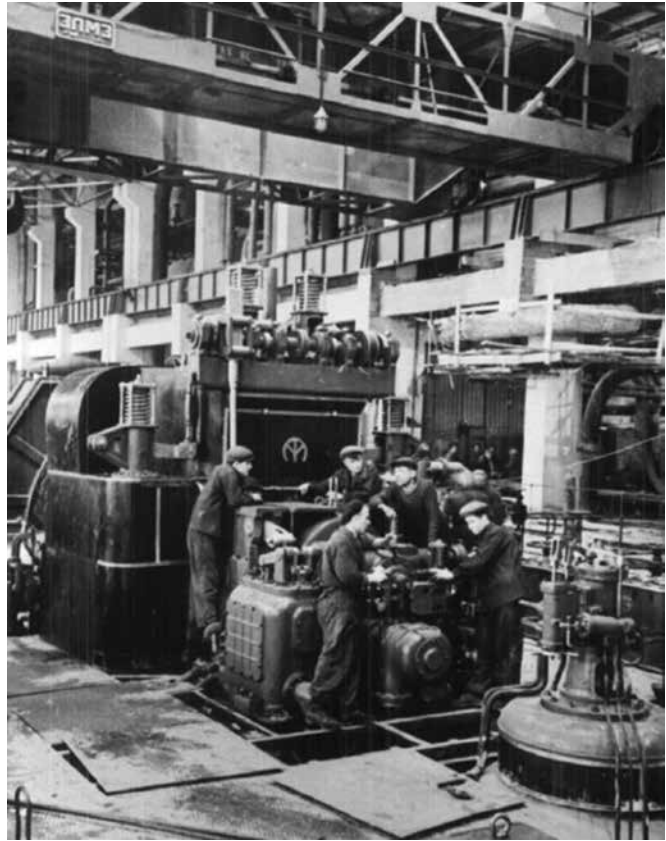
Монтаж турбіни 7-го енергоблоку на Дарницькій ТЕЦ. Фото 1957 р.
