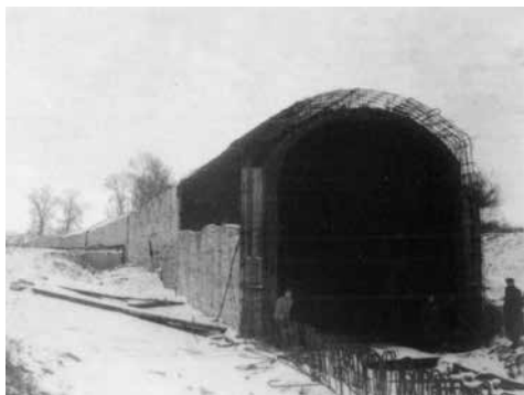
Забетонувана ділянка тунелю. Фото 1940-х рр.
