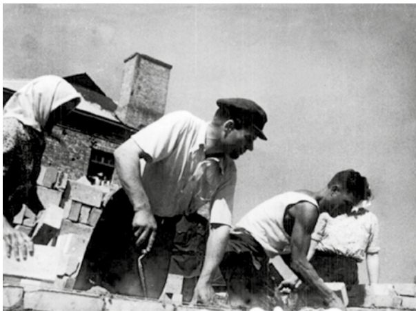
Бригада Івана Рахманіна 1-ї дільниці Управління будівельно-відновлювальних робіт № 2 Південно-Західної на відбудові приміщень ДВРЗ. Фото 1945 р.
