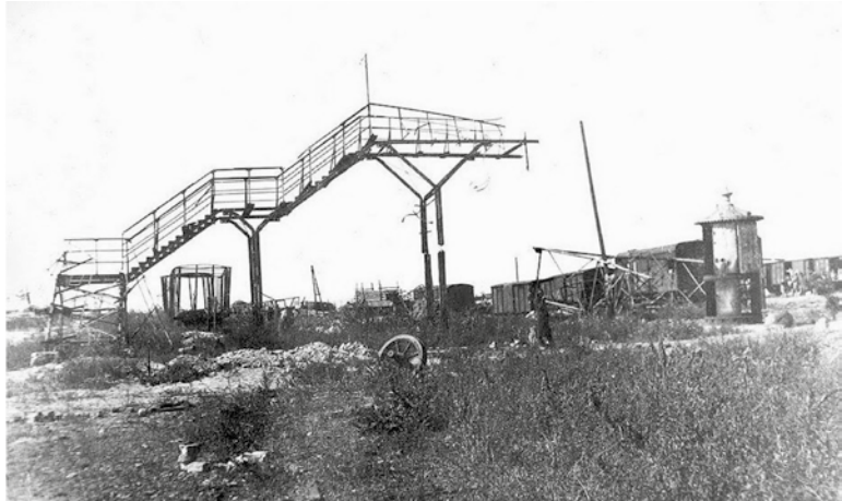
Зруйнований шляхопровід залізничної станції Дарниця. Фото 1944 р.
