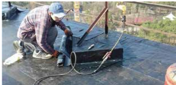
Утеплення будинку і ремонт даху виконують фахівці керуючої компанії.
