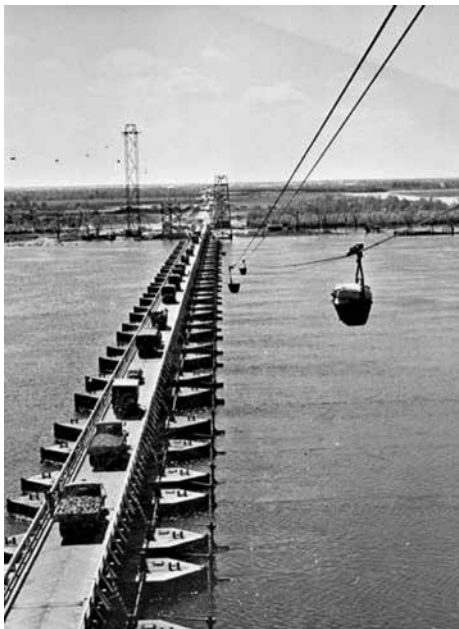
Для переправлення вантажів через Дніпро німці влаштували канатну дорогу. На знімку також видно тимчасовий автомобільний міст через Дніпро, побудований трохи нижче за течією від зруйнованого Дарницького залізничного мосту. Фото 1943 р.
