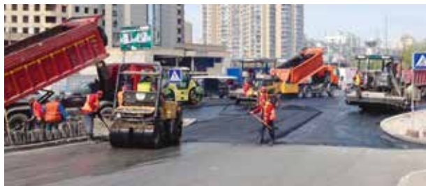
Реконструкція дорожнього покриття на вулиці А. Шептицького в рамках підготовки до «Євробачення-2017».
