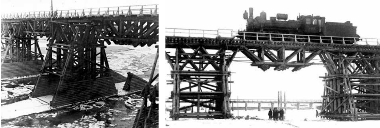
Будівництво «маріїнського» залізничного мосту через Дніпро, фото 1916 р.
