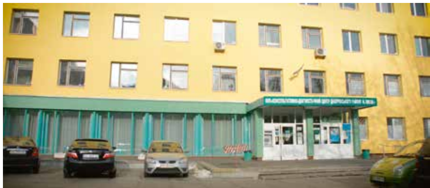
Відремонтований корпус КНП «Консультативно-діагностичний центр Дніпровського району м. Києва», розташований на вул. А. Шептицького, 5.
