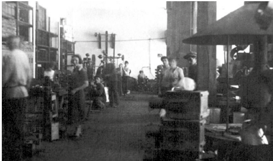
На дільниці виготовлення сигнальних ліхтарів Головних електромеханічних майстерень Південно-Західної залізниці. Фото 1938 р.
