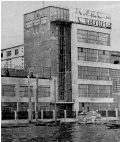
Підтоплення електростанції на Рибальському острові. Фото 1931 р.
