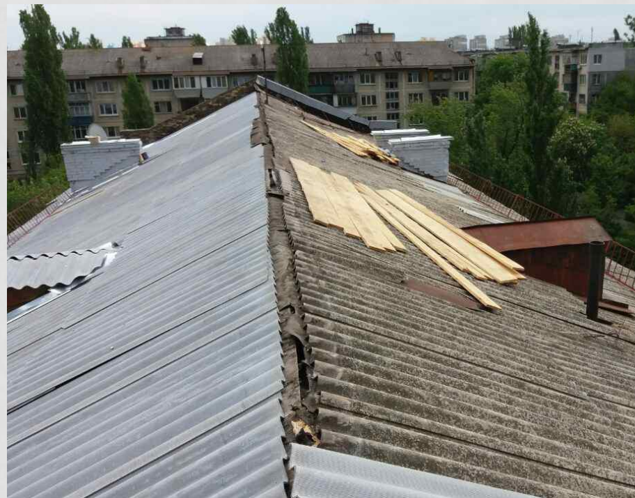
Капітальний ремонт покрівель
