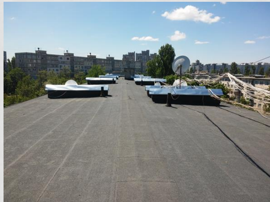
Капітальний ремонт покрівель
