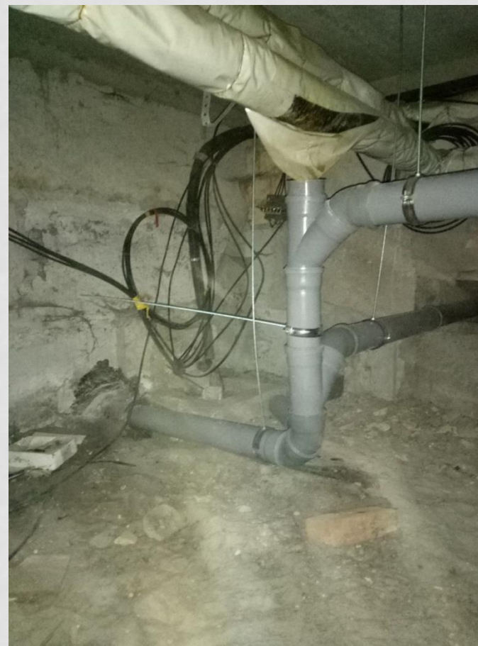
Капітальний ремонт інженерних мереж
