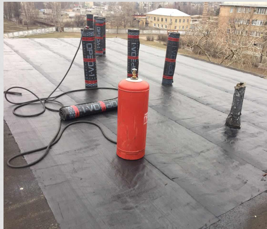
Капітальний ремонт покрівель
