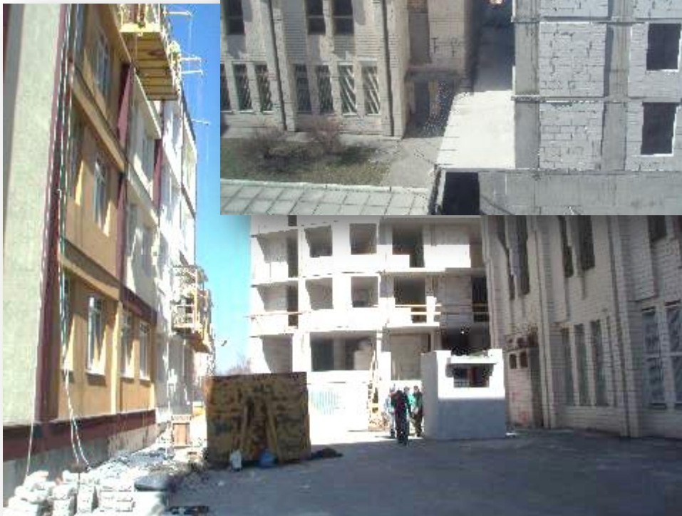
Будівництво житла впритул до ЗНЗ № 317
