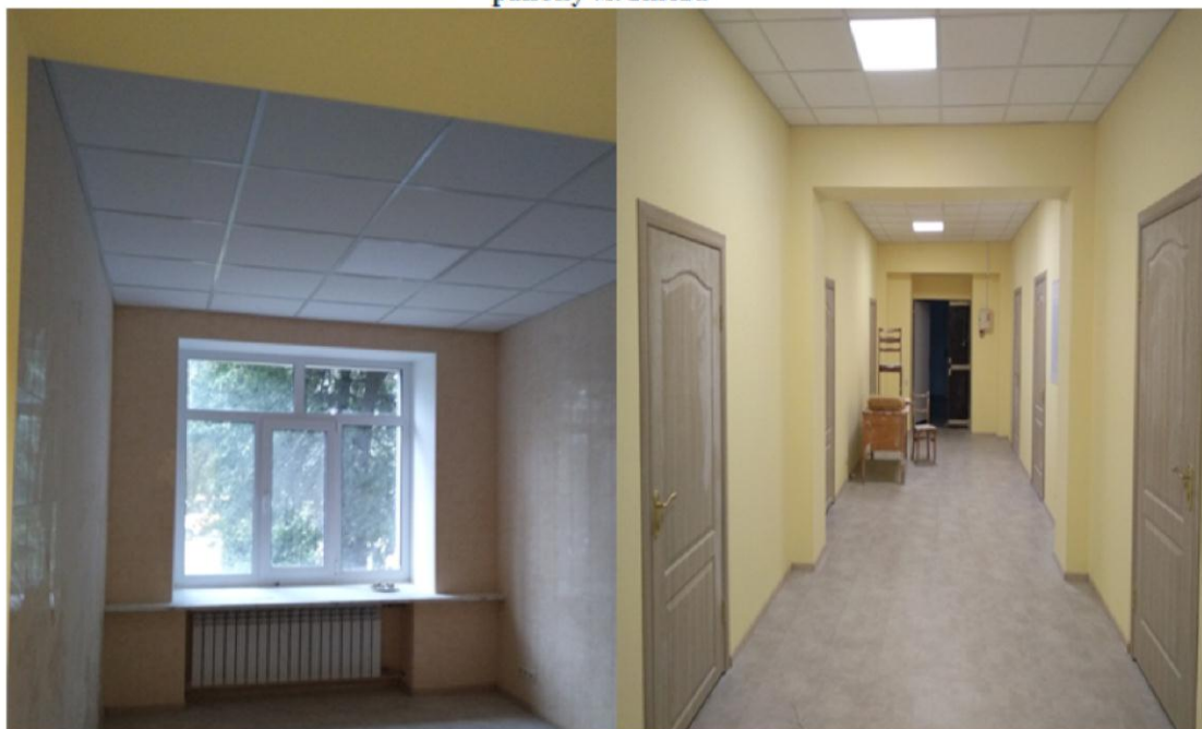
Проведення ремонтних робіт у амбулаторіях КНП «ЦПМСД №2» Солом'янського району м. Києва
