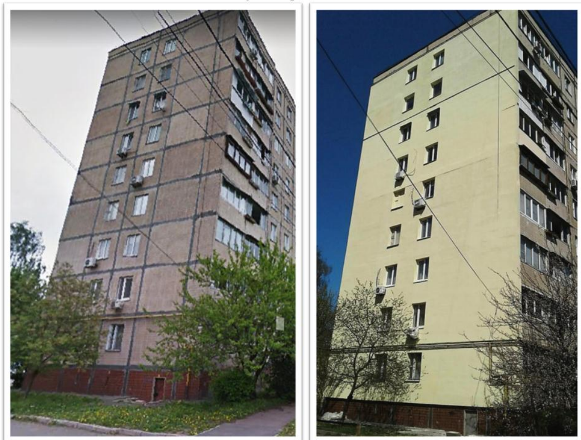
Виконано утеплення фасаду. вул. Патріотів, 98
