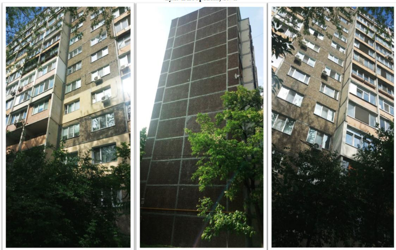
Герметизація швів у житловому будинку вул. Виборзька, 59-а
