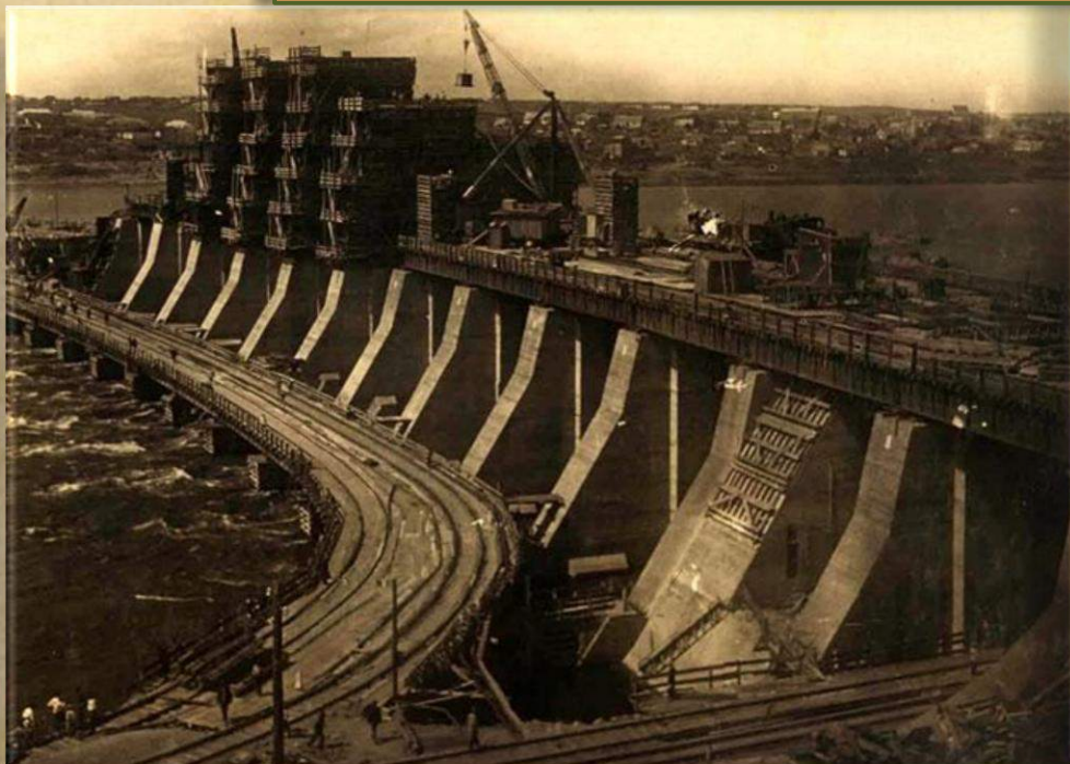
Спорудження Дніпровської ГЕС. Фото 1930 року
