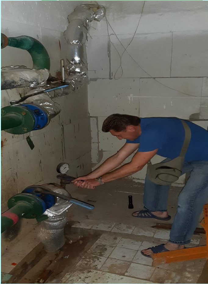
Заміна манометра на системі ЦО, вул. Приймаченка, 3
