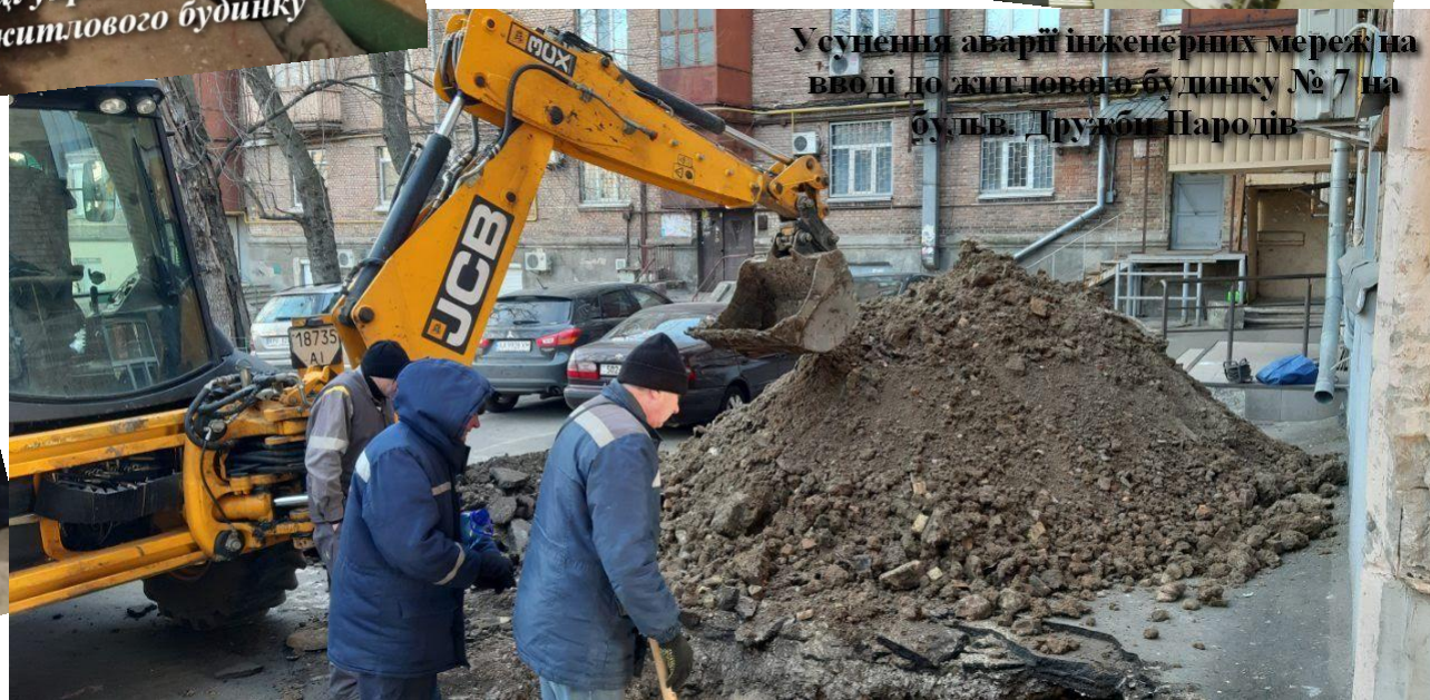
Роботи з часткового ремонту водонесучих інженерних мереж у житловому будинку № 9 на вул. Івана Федорова
