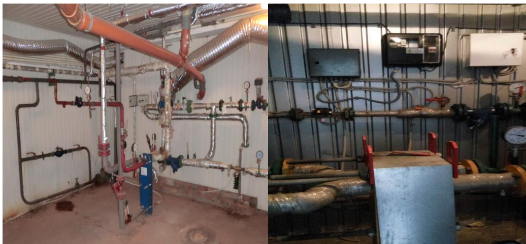
Теплоізоляція трубопроводів та підготовка теплових пунктів в будинках
