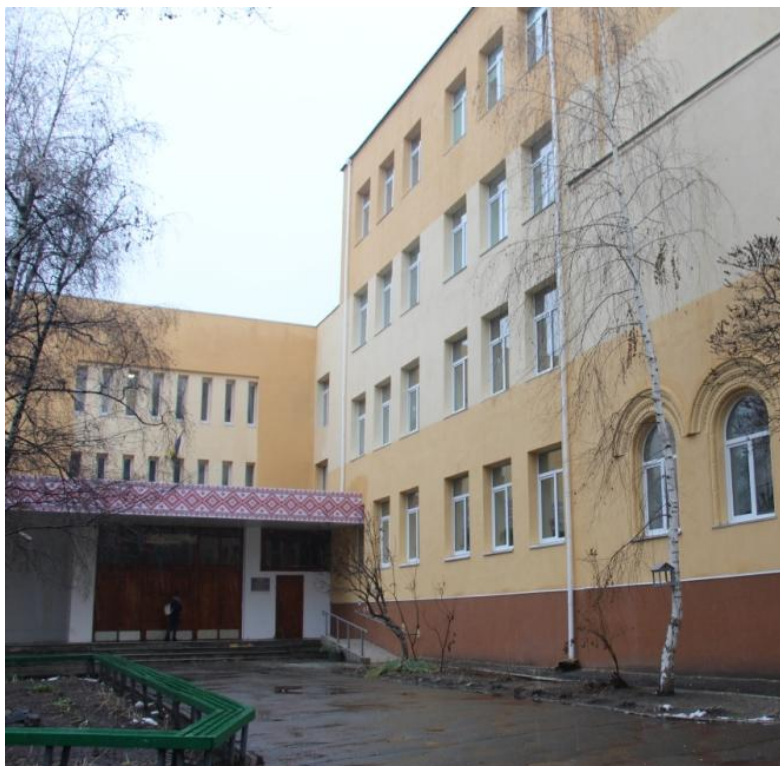
Утеплено фасад загальноосвітнього навчального закладу № 90
