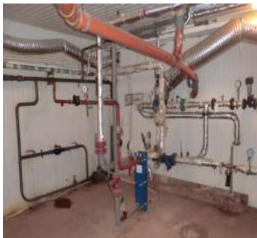
Теплоізоляція трубопроводів та підготовка теплових пунктів в будинках
